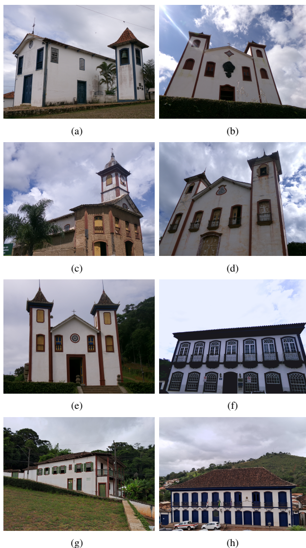
Fig. 2. Monumentos históricos da cidade Serro (MG) (a) Igreja de Nossa Senhora do Rosário (b) Igreja de Nossa Senhora do Carmo (c) Igreja de Santa Rita (d) Igreja Matriz de Nossa Senhora da Conceição (e) Igreja do Senhor Bom Jesus de Matozinhos, (f) Casa do Barão, (g) Museu Regional Casa dos Ottoni e (h) Prefeitura do Serro.
