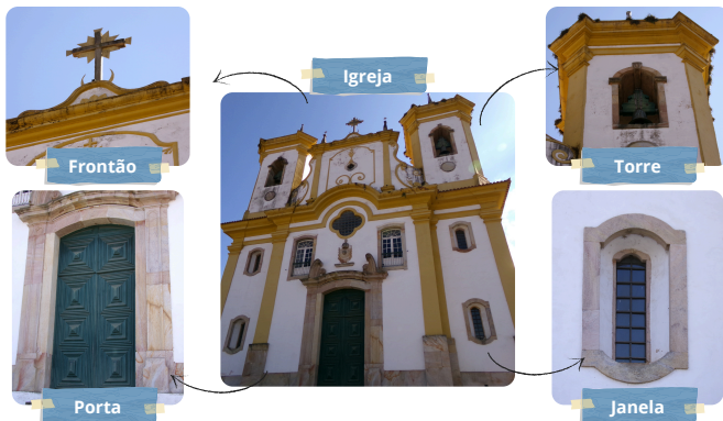
Fig. 4. Classes da base de dados ImageOP: (i) Igreja, (ii) Frontão, (iii) Janela, (iv) Porta e (v) Torre. Exemplo da Igreja Nossa Senhora do Carmo de Ouro Preto MG.
